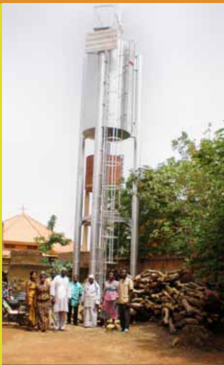
Une de nos réalisations de 2009: château d'eau au centre d'accueil de l'Association Miséricorde pour tous Cardinal Emile Byenda (AM-CEB)
