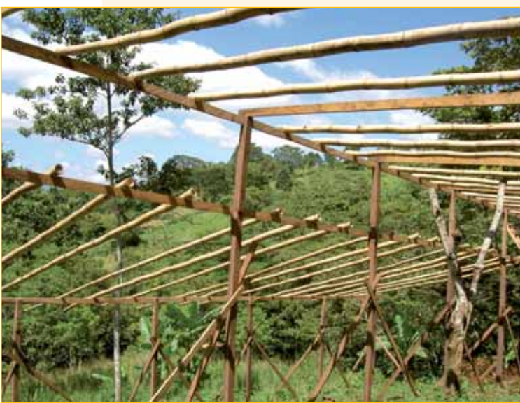
Une serre en construction
