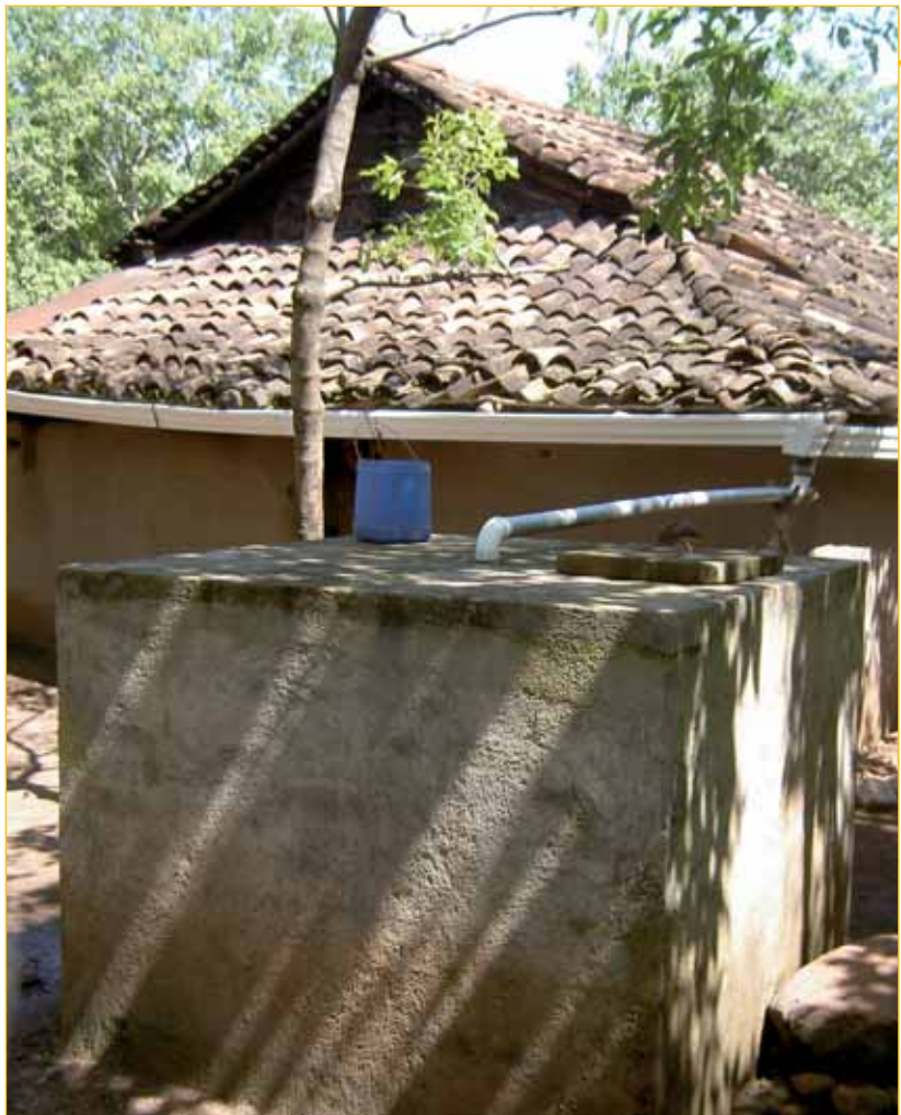
Une citerne familiale construite en 2004 dans le bassin de Maunica. Remplie, elle subvient aux besoins en eau potable d'un ménage de 6 personnes pendant 5 à 6 semaines.
